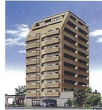
アースコート戸畑千防 <竣工/平成14年10月>
