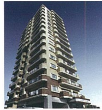
アースコートレトロ門司港 <竣工/平成22年3月>
