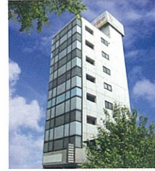
ステーション小倉ビル
