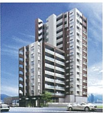
アースコートディアキャナル下関 <竣工/平成25年8月>
