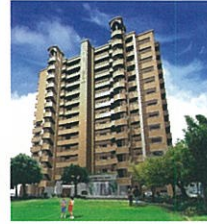
アースコート八幡駅前 <竣工/平成19年5月>
